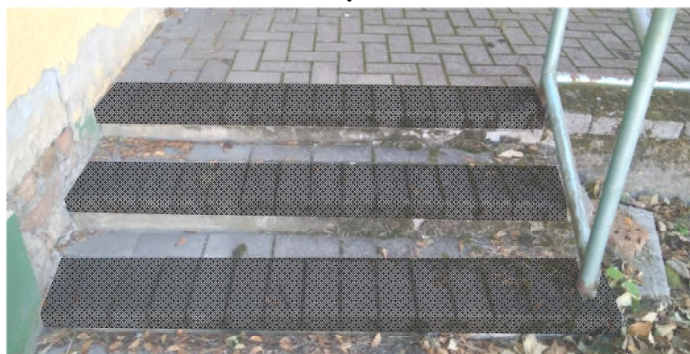
lépcső kontraszt kialakítása átfestéssel
